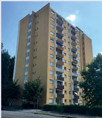
vor der Sanierung
