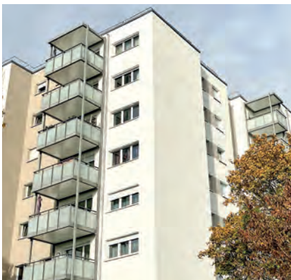
neue WDVS-Fassade, alte Balkone, 11/2023
