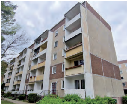
Plattenbauten vor Sanierung
