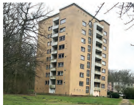
Rabenberg 99 vor der Sanierung, Foto: 03/2024
