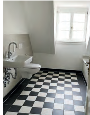
Bad im DG
