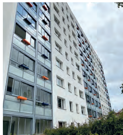
Loggien mit Kaltverglasung, Foto: 04/2024
