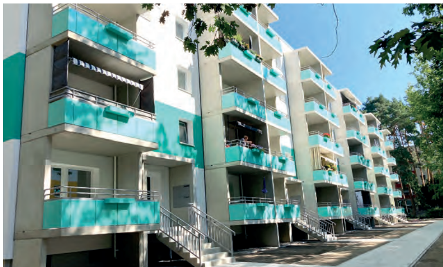
WDVS-Fassade und neue Balkon- u. Eingangsanlagen, Foto: 29.08.2024
