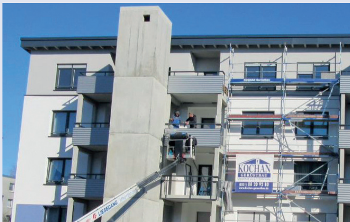
Feldgartenweg 13+15, Aufstockung und Aufzugs-/Balkonanlage
