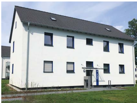
Objekt Werrastraße 18 Hauseingangsseite
