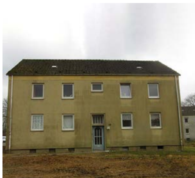
Werrastraße 18 vor der Sanierung
