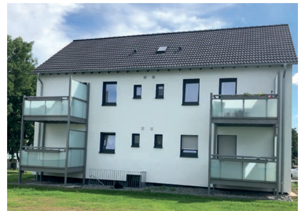
Objekt Werrastraße 18 Balkonanlagen
