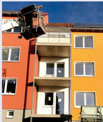
Bau der Balkone
