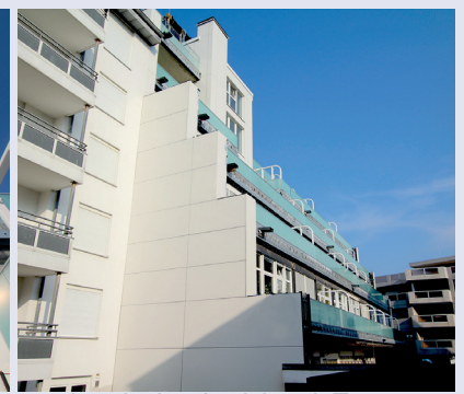
Landseite: Ansicht mit Terrassen
