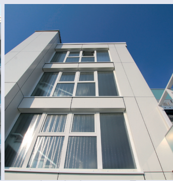
Landseite: neue Fenster
