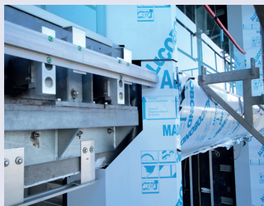
Stahlträger und Glasbrüstung
